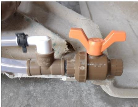
Faça uma conexão com dutos de Ø 20mm da saída do registro até o local de drenagem (ralo). A água será drenada até o nível do dispositivo de drenagem, localizado na região mais baixa do Spa, próximo ao piso.
